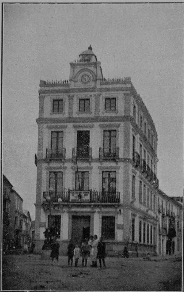
Edificio de la escuela graduada "Romero Robledo,,
